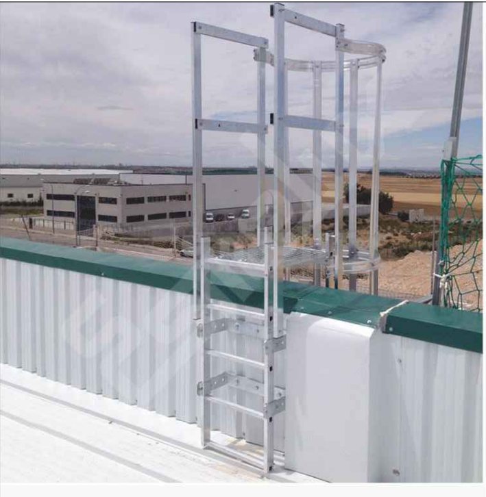
Detalle de escala de acceso a cubierta.
