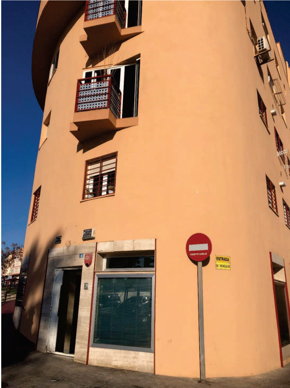
Estado actual Acceso Local desde Av. Donantes de Sangre
