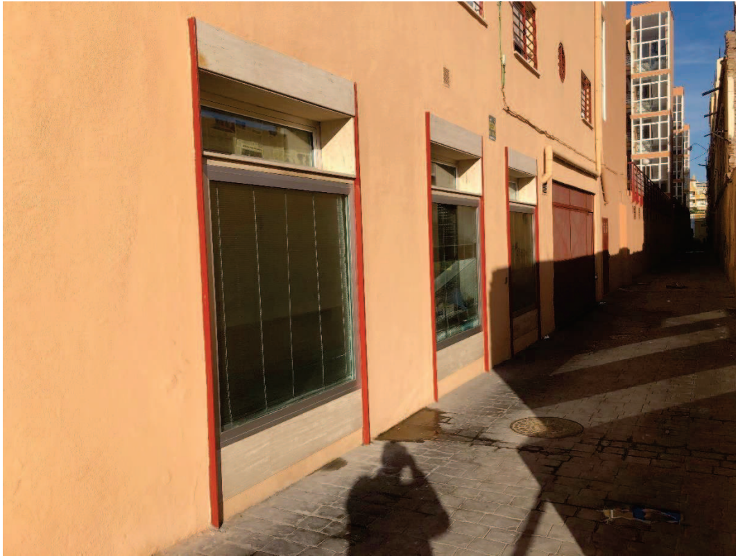
Estado actual Fachada a vial privado.
