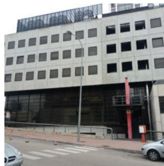
VISTA CUBIERTA. ZONA SUBIDA MATERIALES
