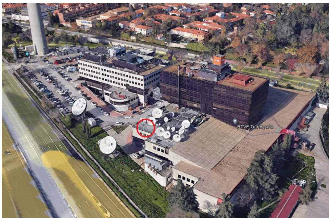
Figura 1 – Cubierta de edificio y ubicación de la nueva antena
