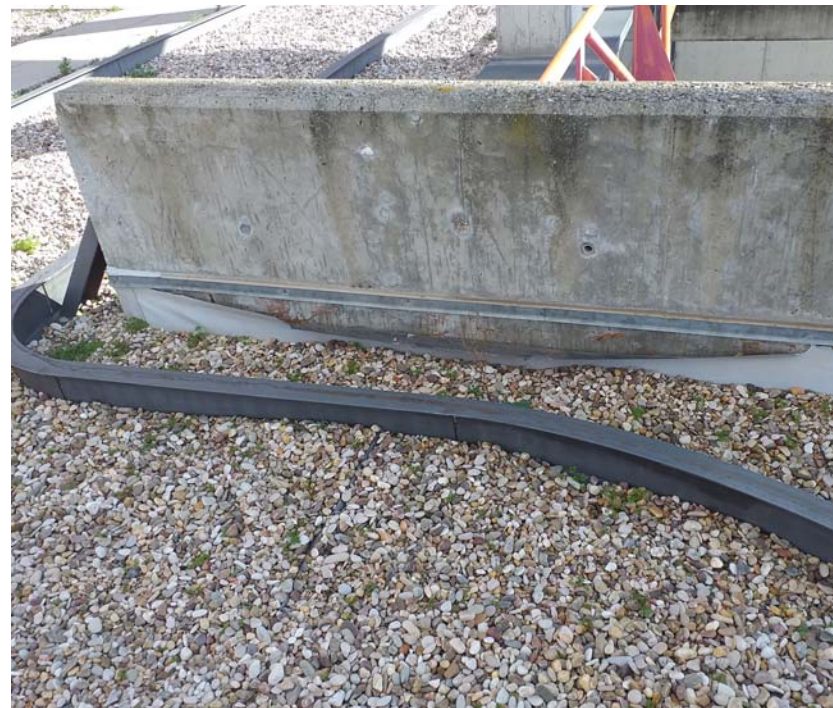
2. IMPERMEABILIZACIÓN DESPEGADA.
