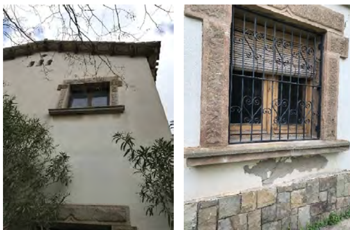
Fotos de Fachada
