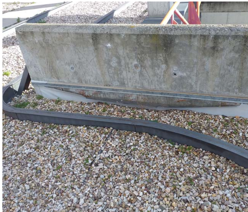
2. IMPERMEABILIZACIÓN DESPEGADA.
