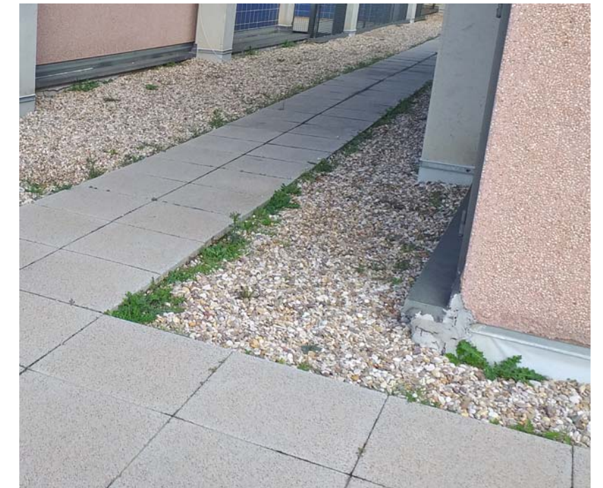
4. ENCUENTRO DE VIERTEGUAS CON PARAMENTO VERTICAL.
