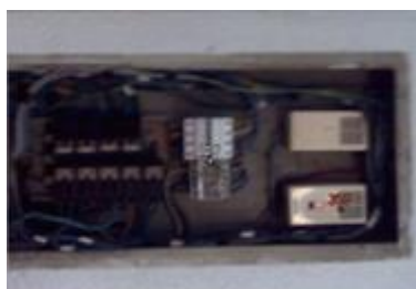
CUADROS EN PASILLOS CENTRALES PUNTO 3
