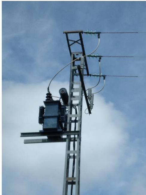
APOYO TRANSFORMADOR
