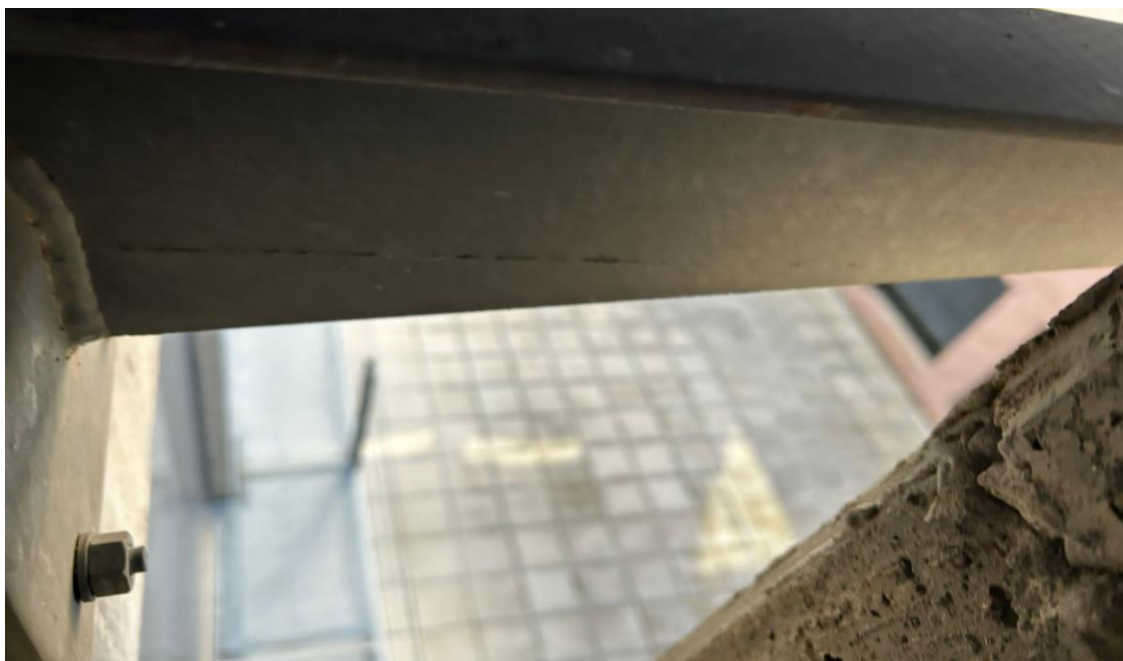
Fotografía 3. Anclaje viga soporte Pasarela Torrespaña 1.2.
