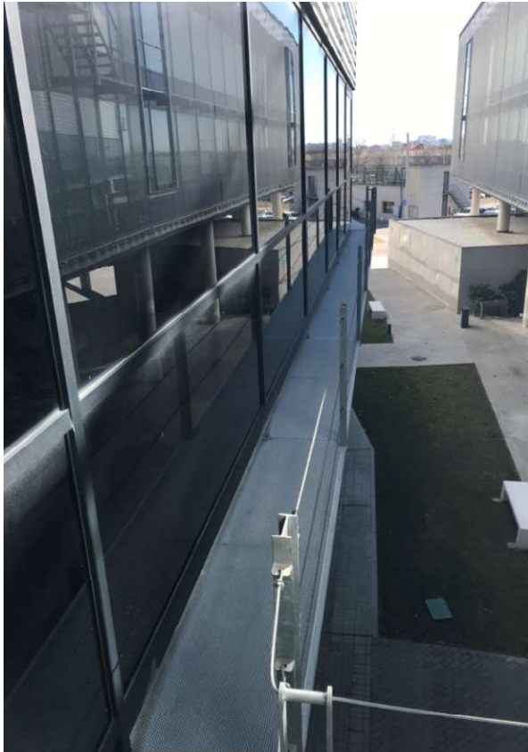
Fotografía 1. Pasarela de planta 1ª
