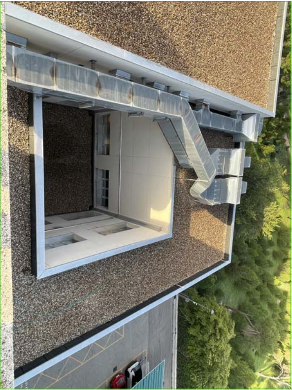
17. DISPOSICIÓN GENERAL DE CONDUCTOS EN CUBIERTA
