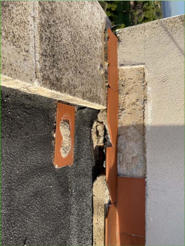
14. ZÓCALO DETERIORADO
