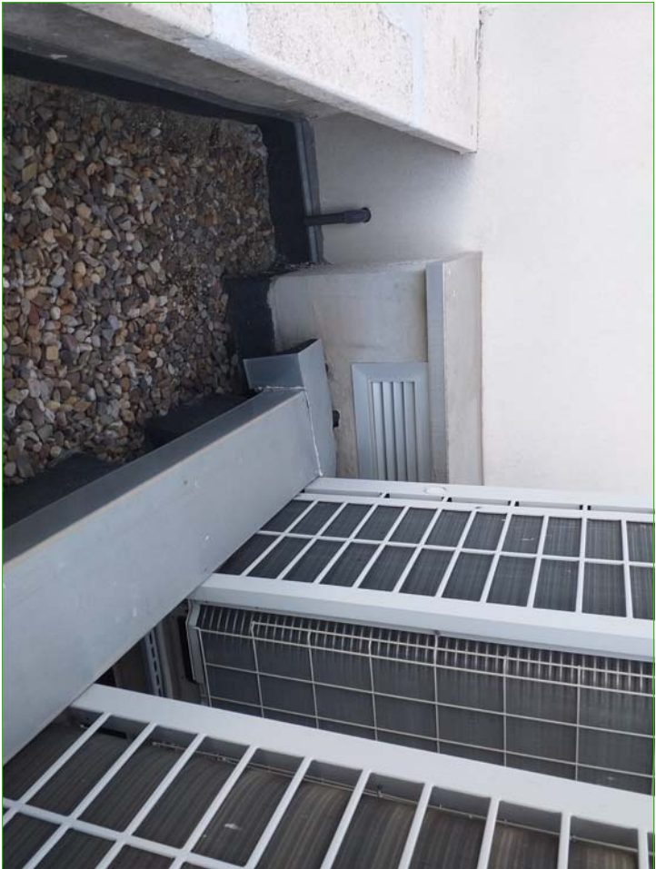
31. ZONA INSTALACIONES CUBIERTA PLANTA 2ª
