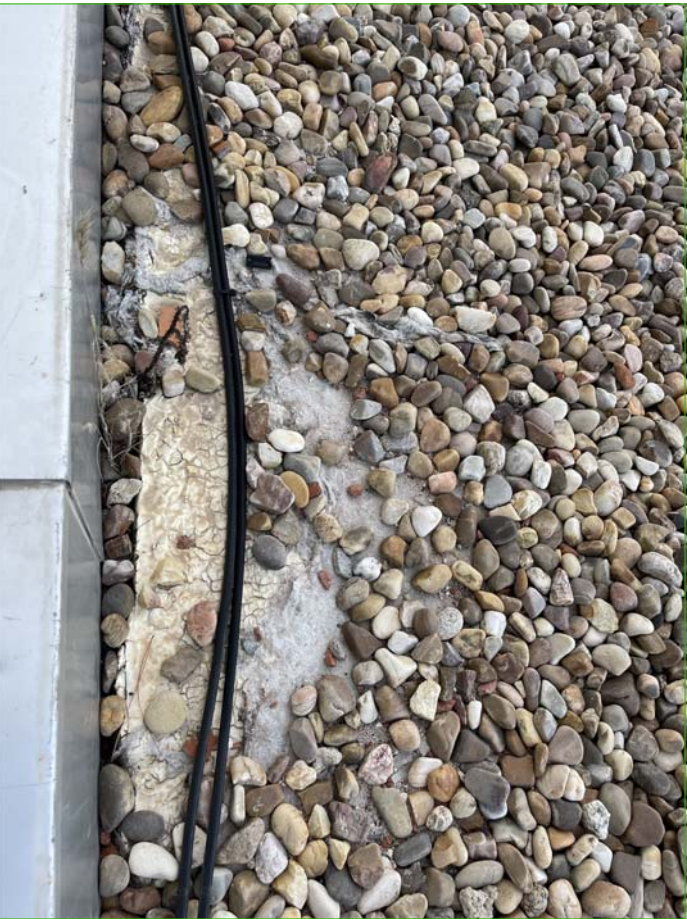
21. ESTADO ACTUAL DE LA COMPOSICIÓN DE LA CUBIERTA
