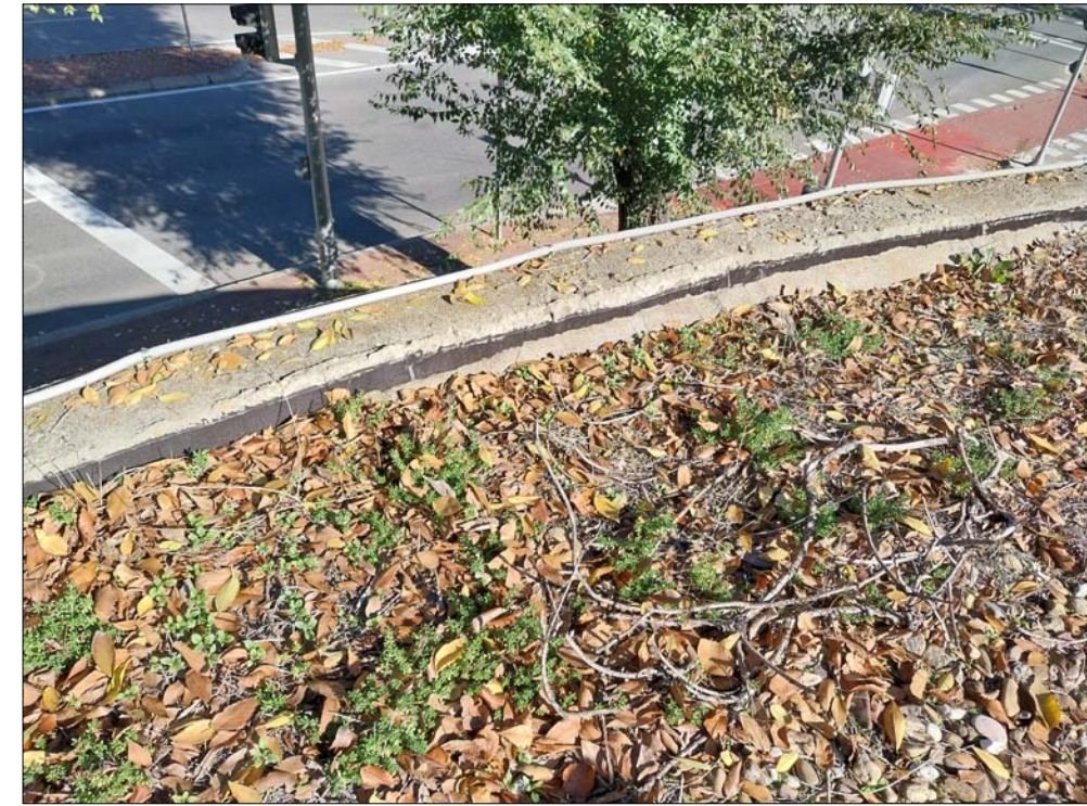
06. VEGETACIÓN EN CUBIERTA
