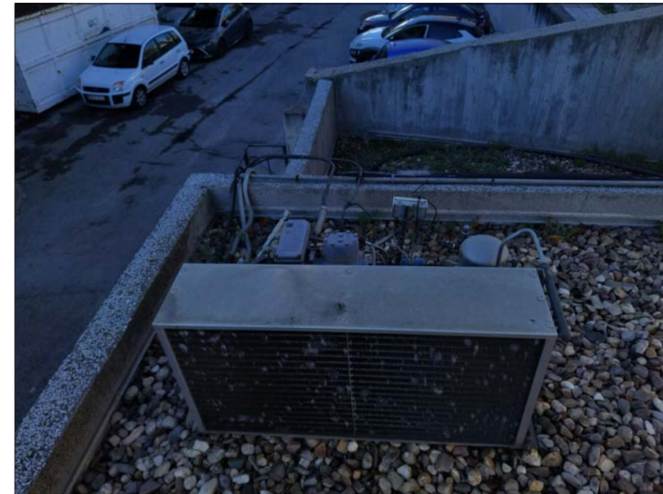
11. EQUIPO DE CLIMA A DESMONTAR
