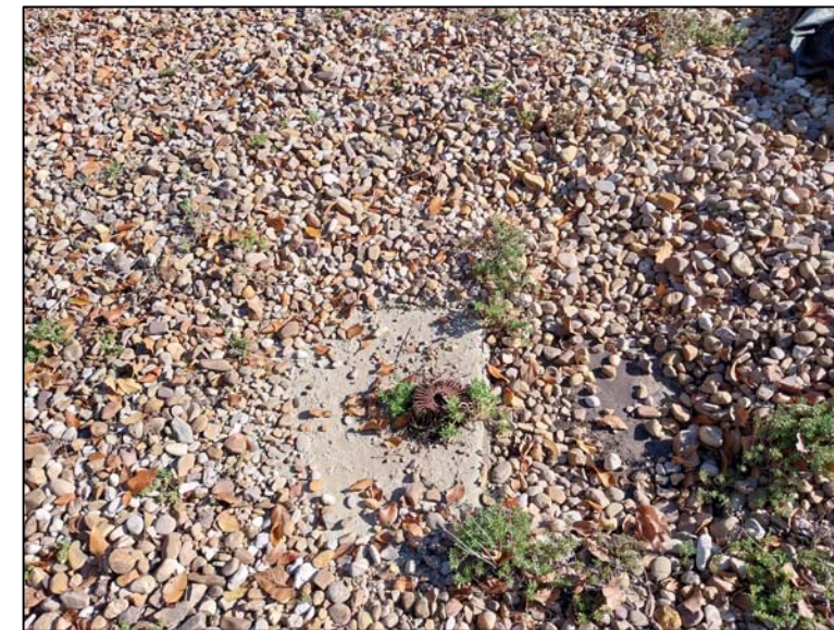
04. SUMIDERO DE CUBIERTA
