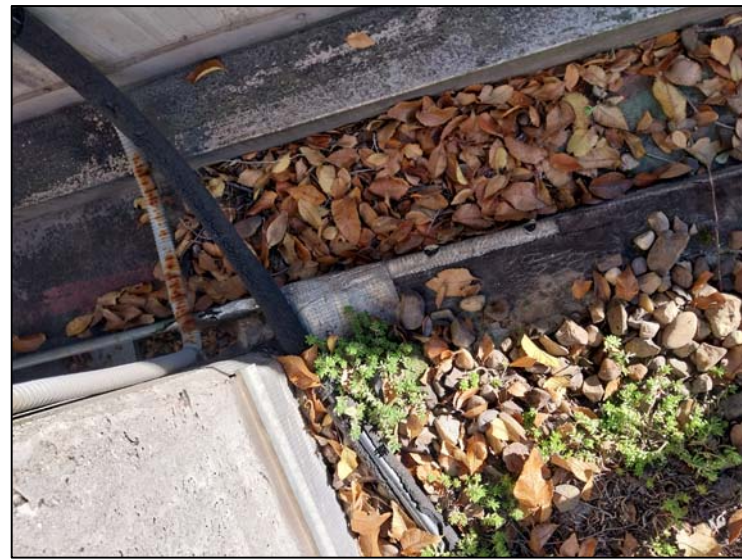
02. CANALÓN DE CUBIERTA
