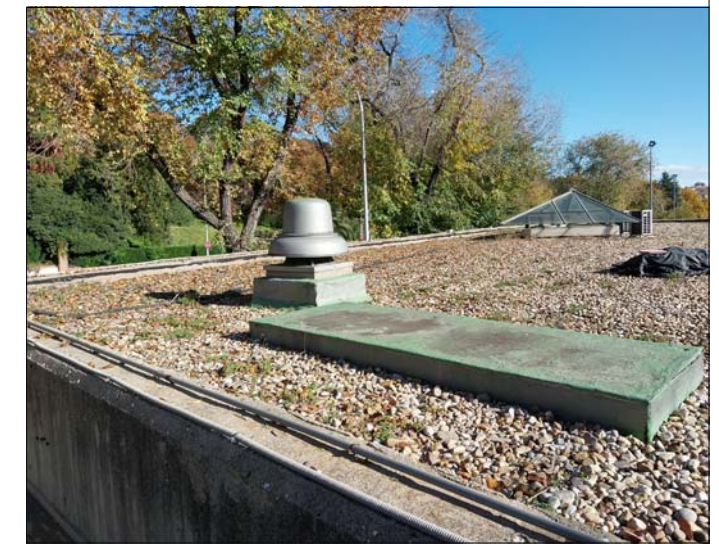
10. CHIMENEA DE VENTILACIÓN Y BANCADA
