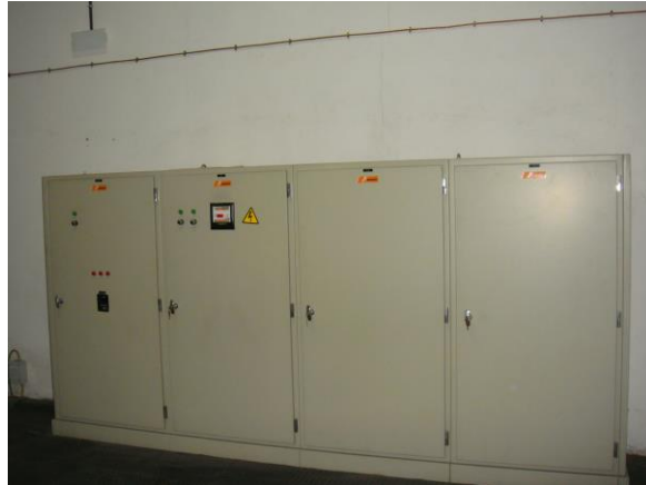
Foto 5 Cuadro baja tensión salida a CGBT
