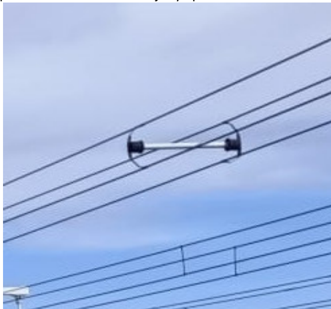
Ejemplo de un aislador con orejas ya presente en el centro emisor.
