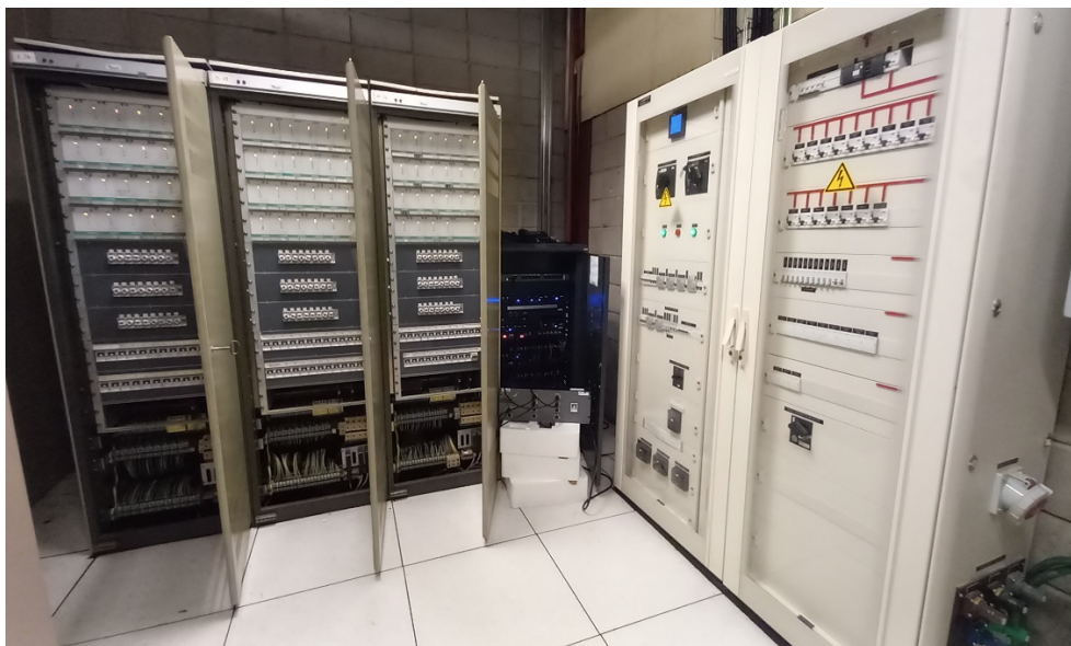
Imagen del armario de dimmers abierto.
