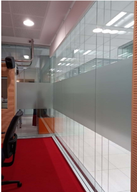
Doble caja acústica independiente realizada con mampara de vidrio
