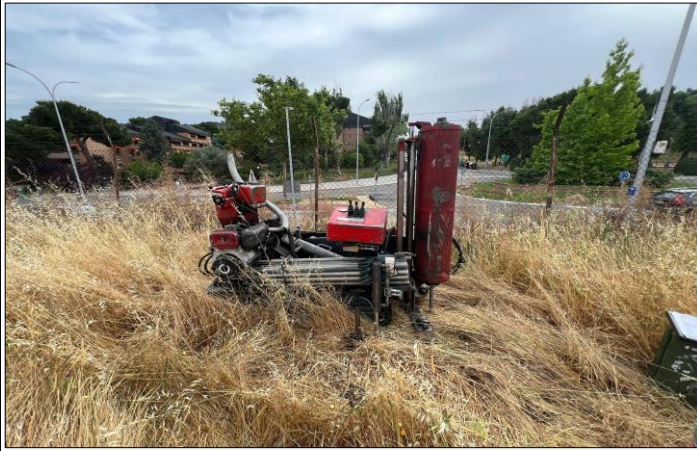
1. Fotografía de emplazamiento P-1
