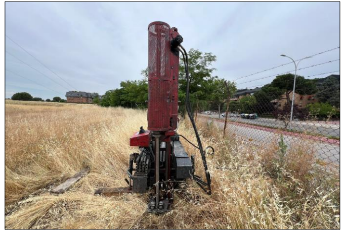
2. Fotografía de emplazamiento P-2
