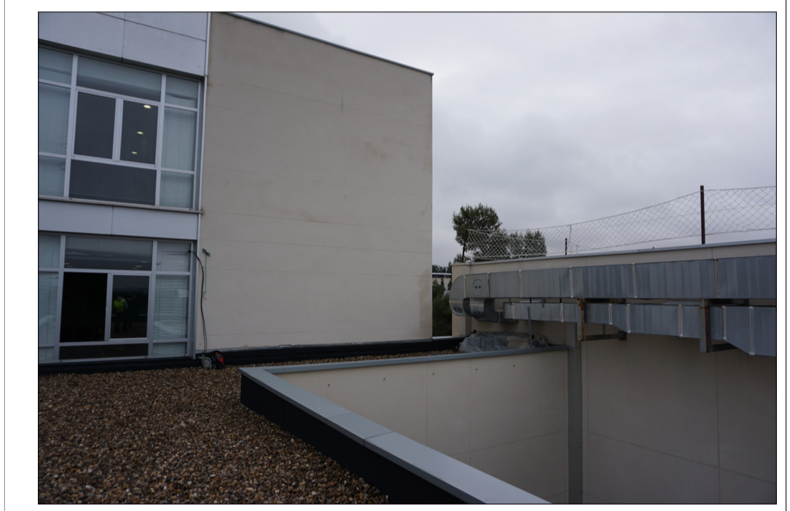
FOTOGRAFIA 1, UBICACIÓN NUEVO ACCESO A CUBIERTA
