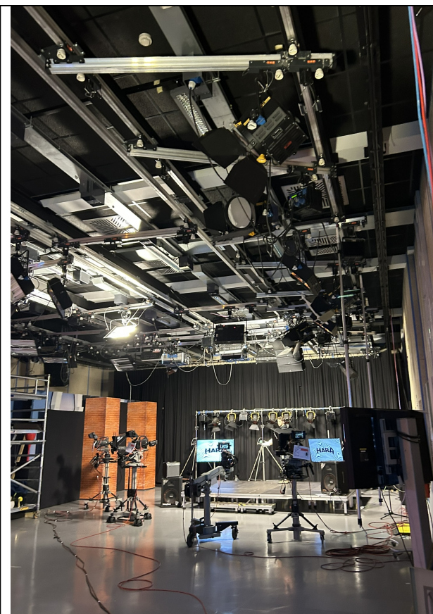
Interior del plató. La cantidad de instalaciones del mismo desaconseja cualquier actuación desde el interior, tanto por motivos económicos como por la pérdida temporal de uso.
