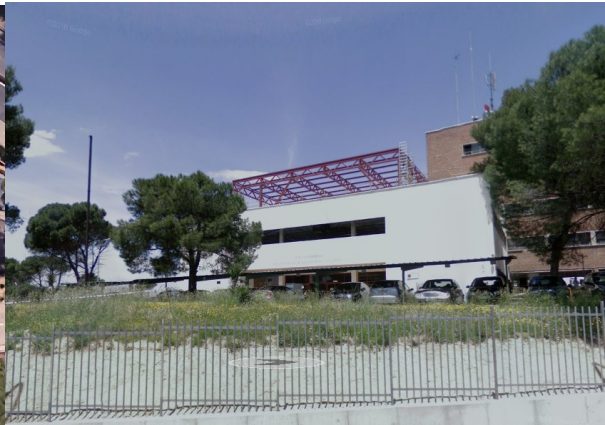
Vista de la ampliación en construcción, 2008
