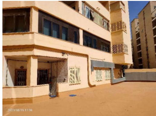
Fachada sala de aparatos a terraza
