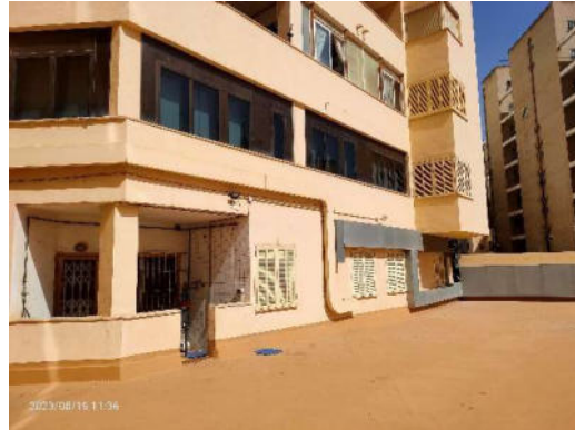
Fachada sala de aparatos a terraza
