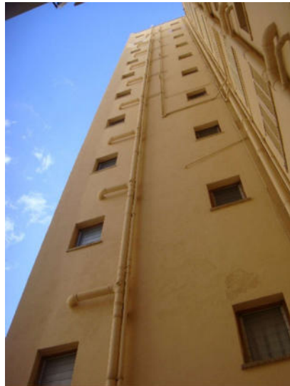
Patio interior, subida futuras tuberías a equipos DAIKIN
