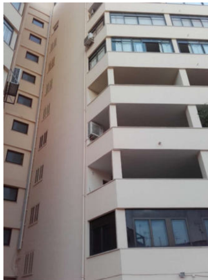
Fachada patio, futura subida tuberías a equipos DAIKIN
