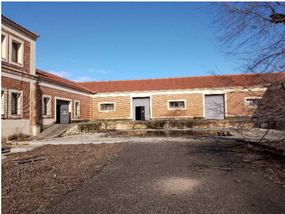
Almacén – Taller. Fachada principal
