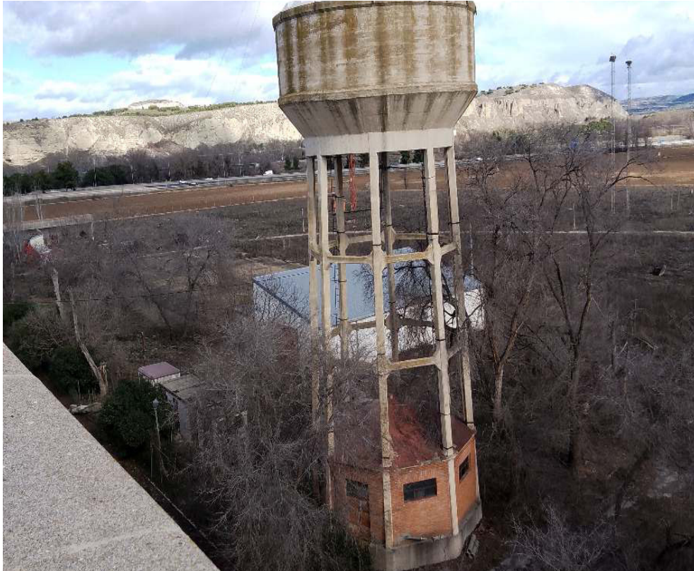
Depósito (en primer plano) y Almacén auxiliar (detrás del depósito)
