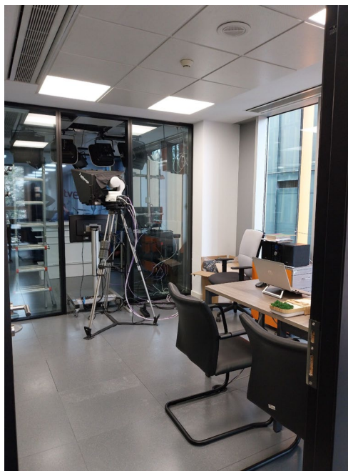
Módulos de mampara a retirar.
