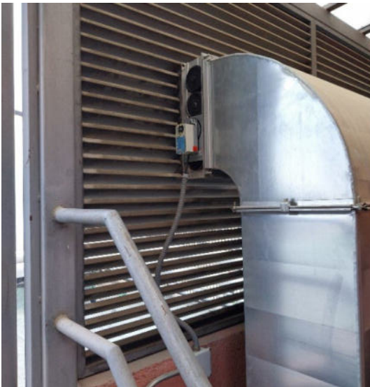
CONDUCTO AE Y COMPUERTAS CLIMA SALA SAIS
