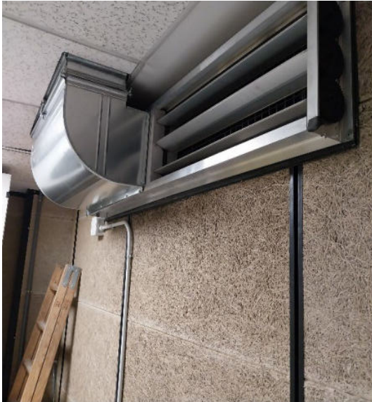
CONDUCTO AE Y COMPUERTAS CLIMA SALA SAIS
