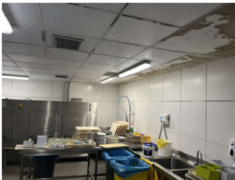
ZONA DE LAVADO
