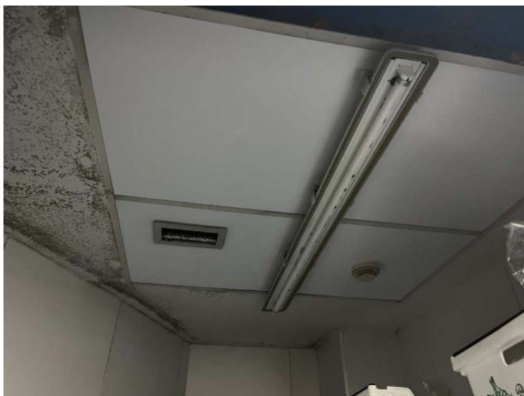
ALMACÉN DE LA SALA DE LAVADO
