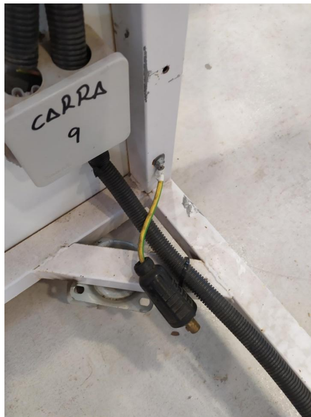
Fotografía de instalación de toma de tierra.
