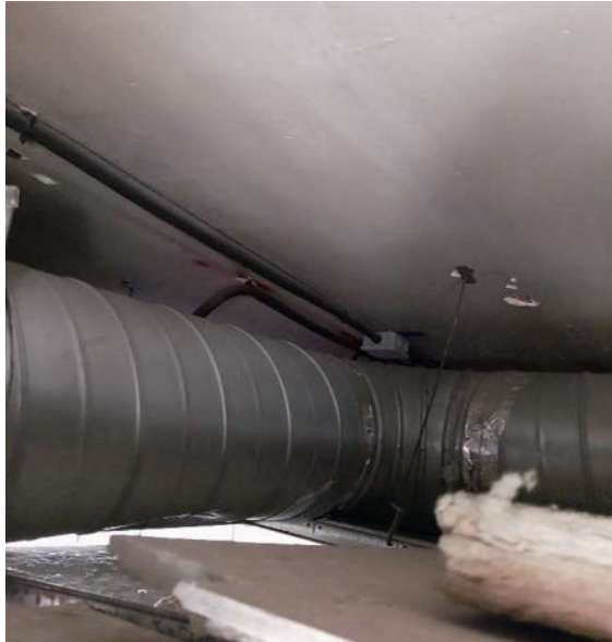
CONDUCTO EXTRACCION CAMPANA EN FT
