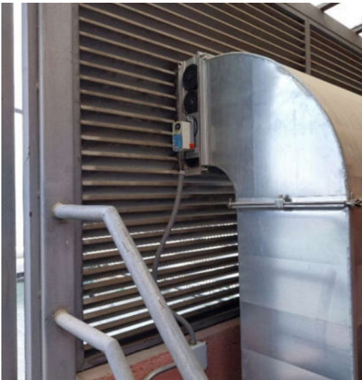
CONDUCTO AE Y COMPUERTAS CLIMA SALA SAIS
