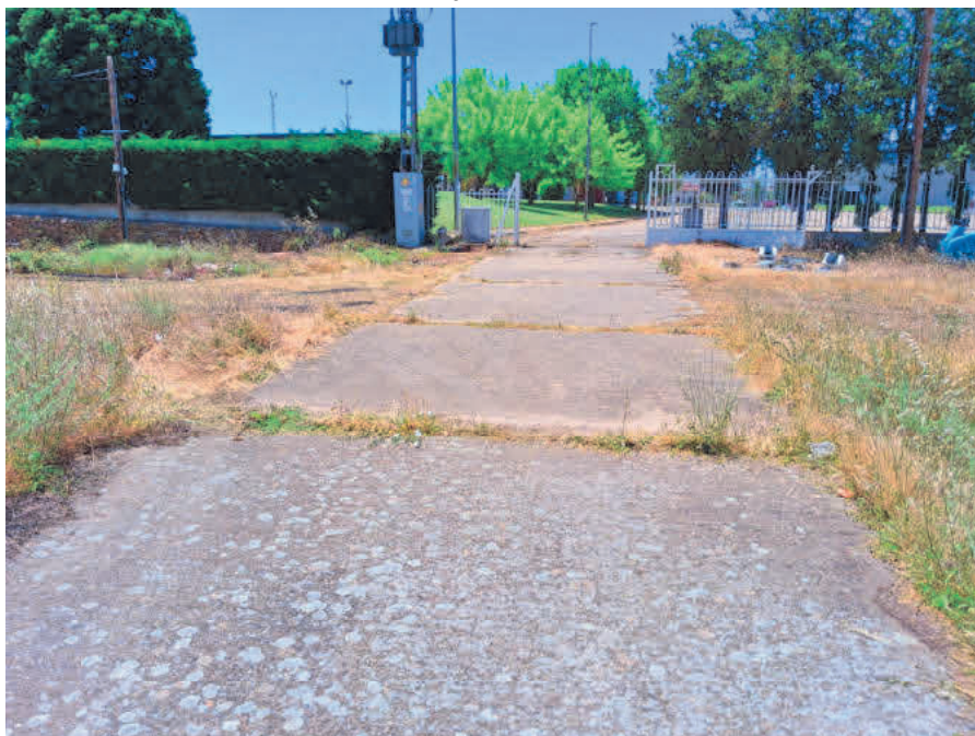
Puerta de acceso y solera de comunicación con edificio
