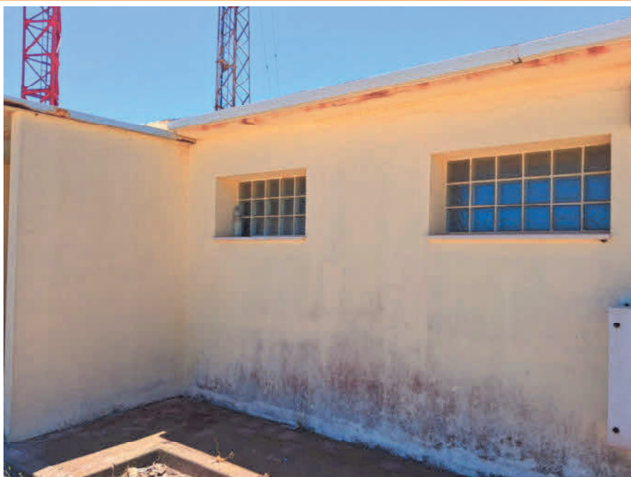
Fachada principal derecha
