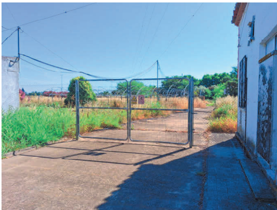
Cerramiento de acceso al mástil
