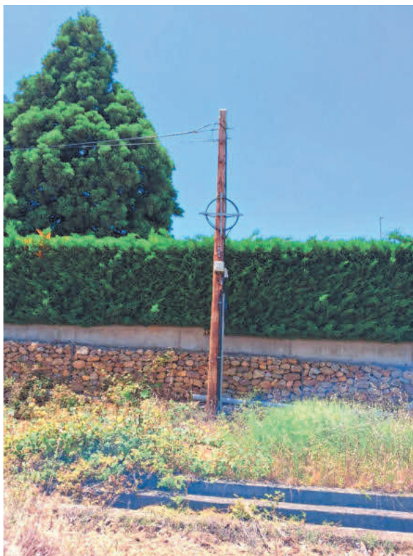
Poste de electricidad junto a acceso
