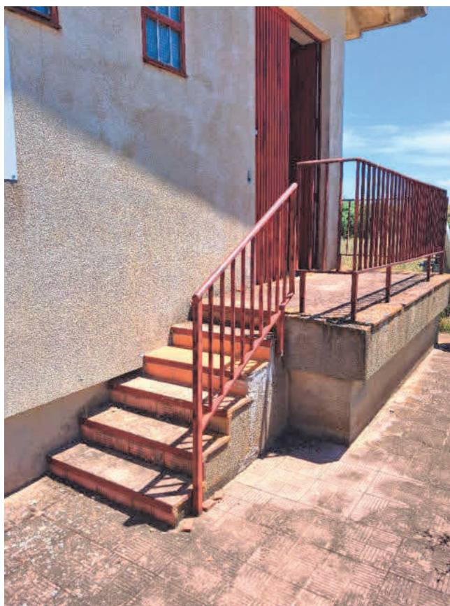
Edificación. Detalle acceso.
