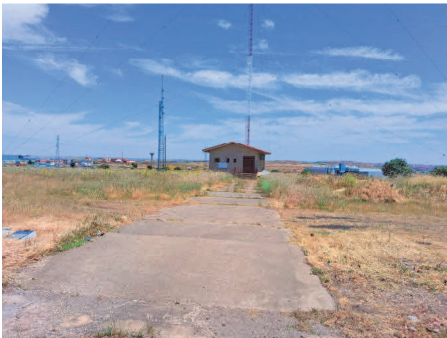
Vista general edificio, torre, mástil, solera acceso
