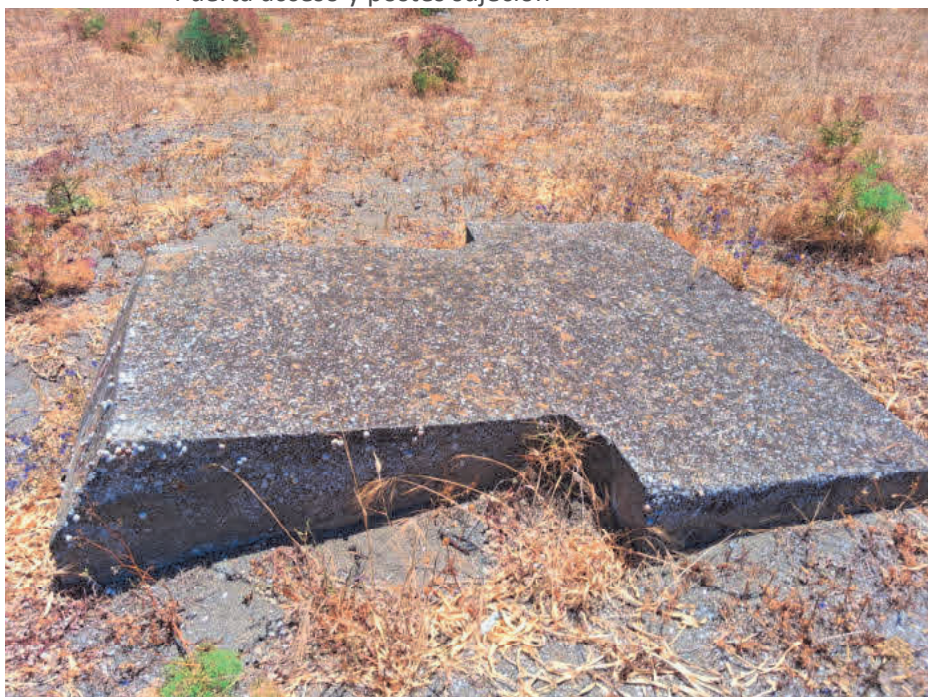
Dado de hormigón
