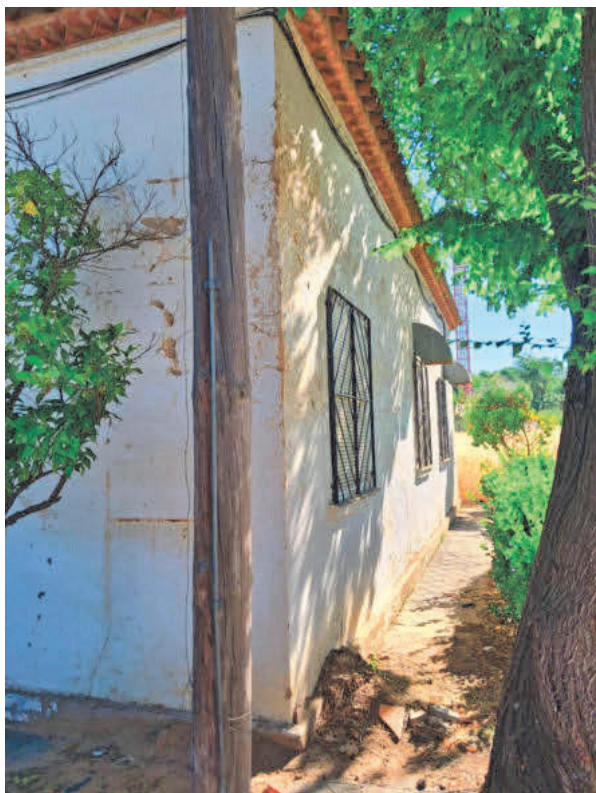
Poste y acerado
