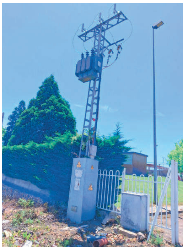
Torre junto a acceso
