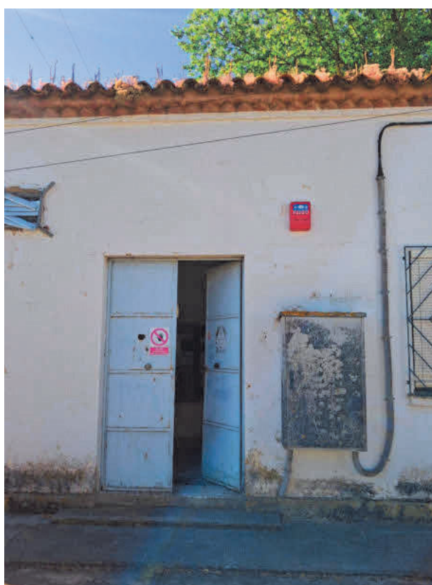
Acceso edificio y cuadro
