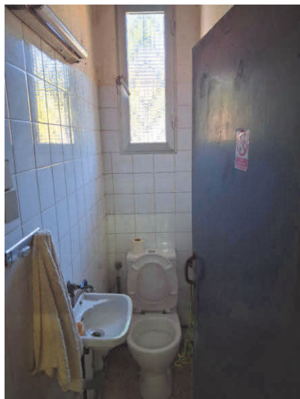
Aseo del edificio
