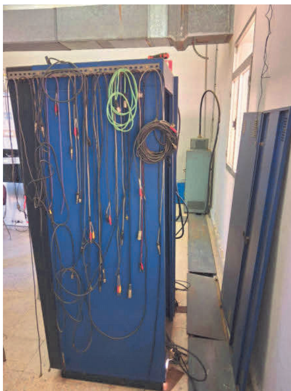
Interior del edificio
