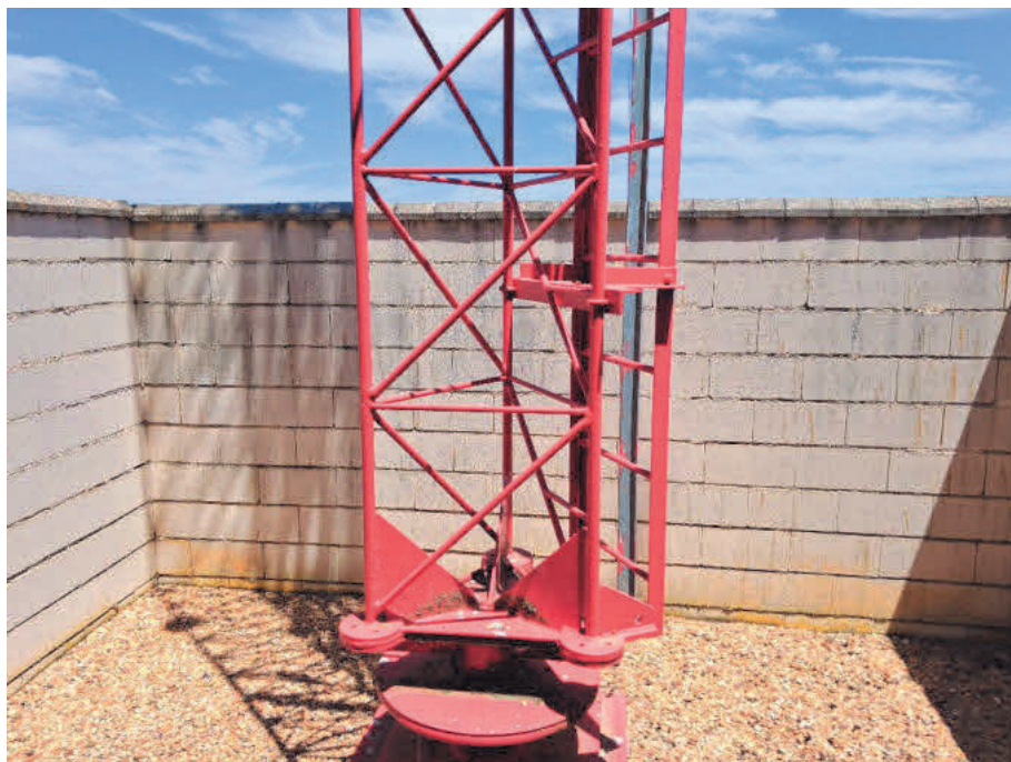
Zona mástil y cerramiento.
